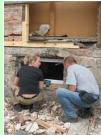
Auszubildende leisten Instandsetzungsarbeiten in der Gedenkstätte Mauthausen
